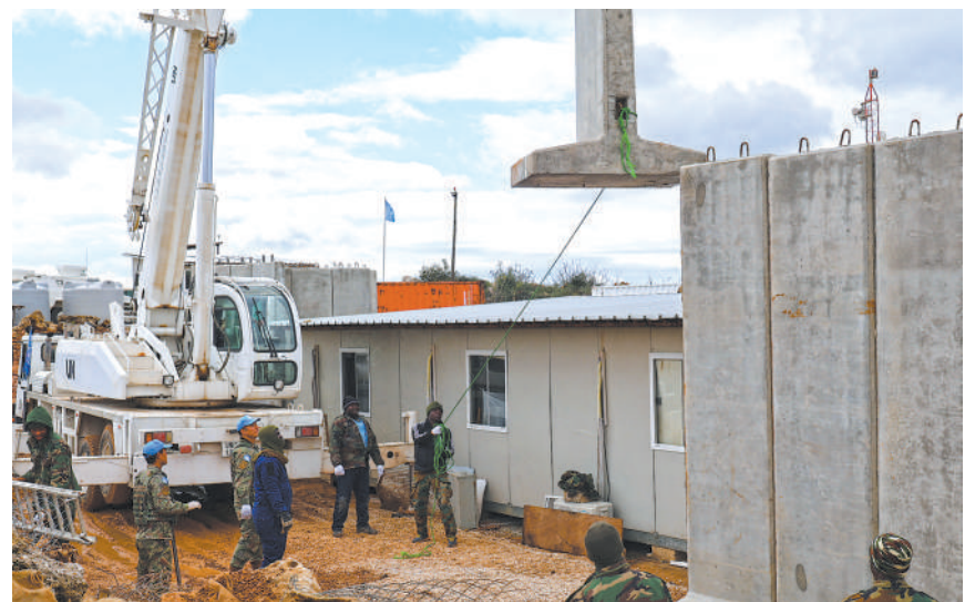
经过3天连续奋战，中国第22批赴黎巴嫩维和建筑工兵分队于2月1日顺利完成维和营区防御设施修建任务，提升了该营区防护水平。图为维和工兵在施工期间吊装防护墙。庄小好摄
