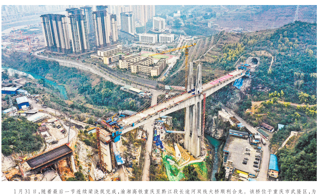
1月31日,随着最后一节连续梁浇筑完成,渝湘高铁重庆至黔江段长途河双线大桥顺利合龙。该桥位于重庆市武隆区,为全线控制性工程之一。图为长途河双线大桥施工现场。 新华社记者 唐奕摄
