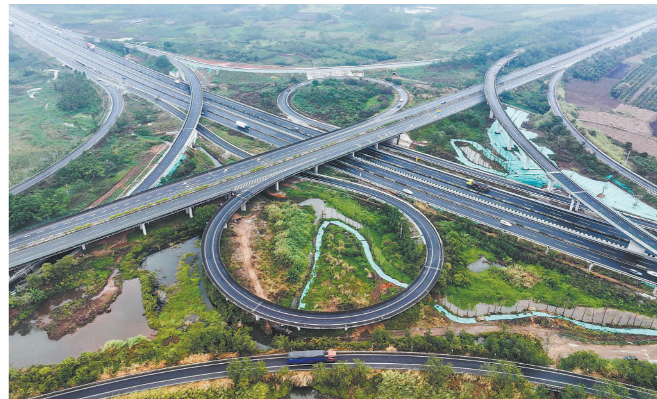
目前,中铁十一局承建的沈海国家高速茂湛段(起于广东茂名市电白区,终于广东湛江市麻章区)改扩建工程临近收官。图为1月23日拍摄的东坡岭枢纽(位于湛江市遂溪县)。 新华社记者 刘大伟摄
