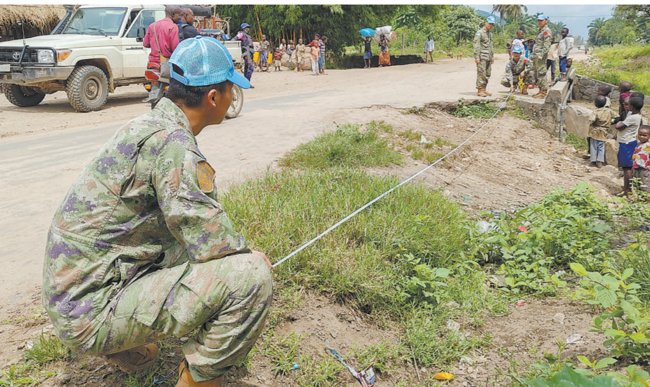
近日,中国第27批赴刚果(金)维和工兵分队乌维拉分队完成N5公路鲁特姆巴民事总部以东7公里路面勘察任务。下一步,分队将依据勘察结果拟制施工方案,并展开道路修复任务。图为官兵现场勘察受损路段。张琦摄
