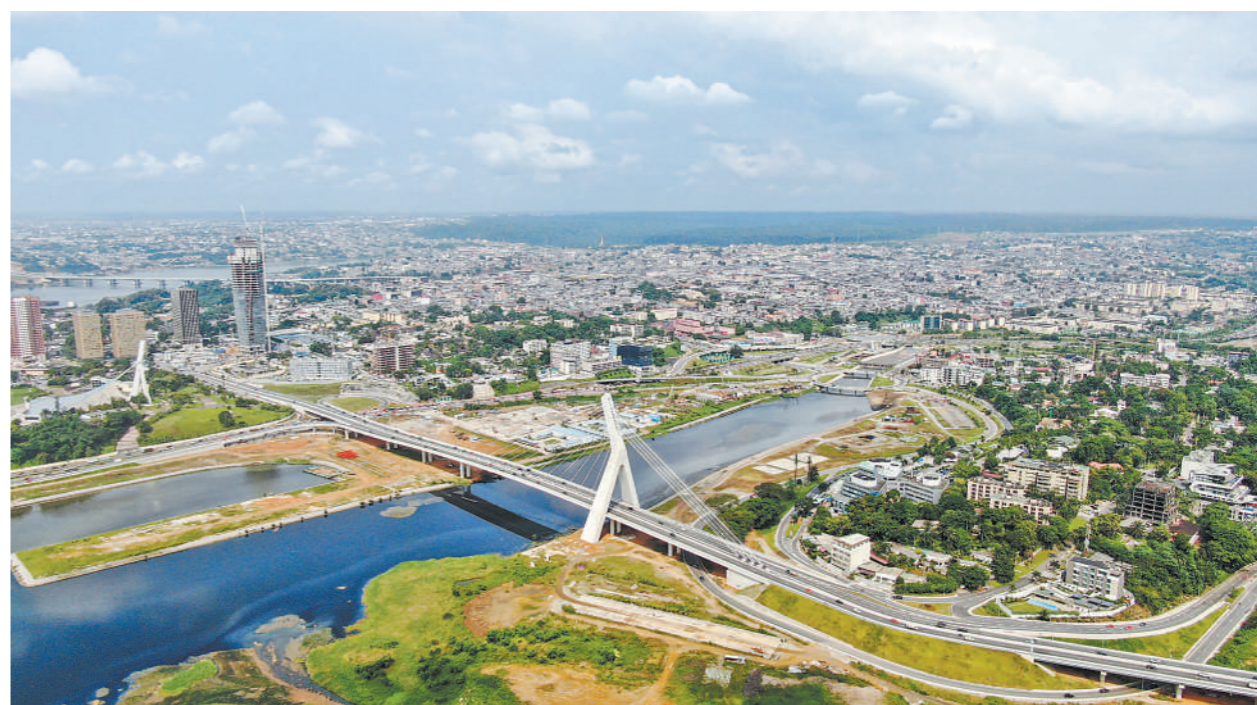
由中国路桥工程有限责任公司承建的科特迪瓦经济首都阿比让科科迪桥项目主线总长约1.63公里。作为一项改善民生的工程,科科迪桥有效缓解了阿比让市区交通拥堵问题。目前科科迪桥已成为阿比让的新地标之一。图为1月9日在阿比让拍摄的科科迪桥。
