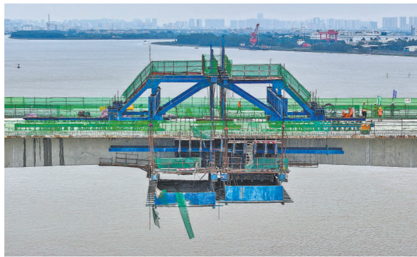
12月17日,广东江门银洲湖高速公路重点控制性工程潭江特大桥主跨全幅合龙(无人机照片)。新华社记者 刘大伟摄
