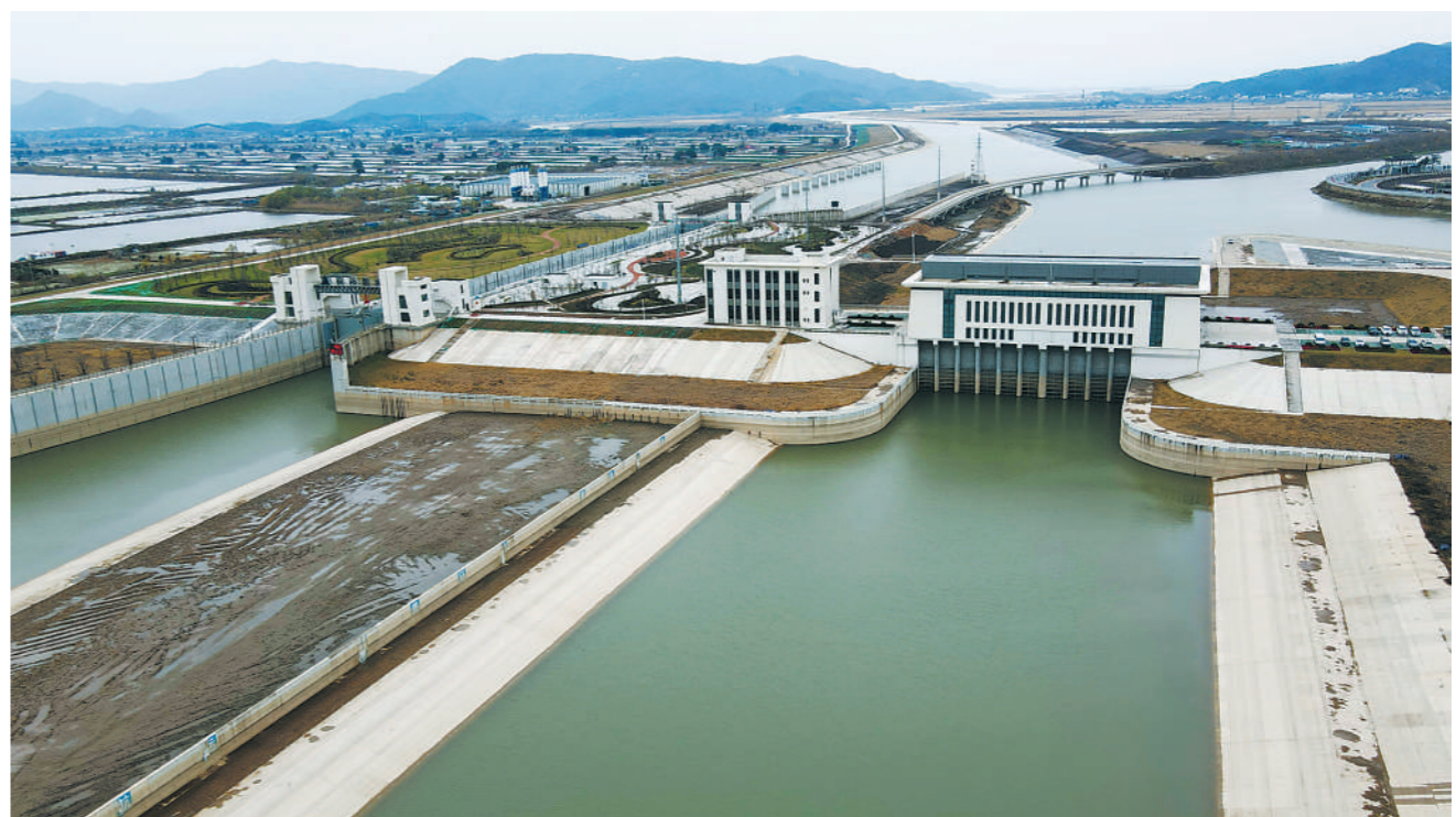
12月16日,坐落在安徽省南部的引江济淮枞阳泵站启动3台大型水泵将长江水引入河道,标志着引江济淮一期工程安徽段正式开启试调水。引江济淮工程是中国172项节水供水重大水利工程之一,集供水、航运、生态等功能于一身。图为当日拍摄的引江济淮枞阳泵站(无人机照片)。
