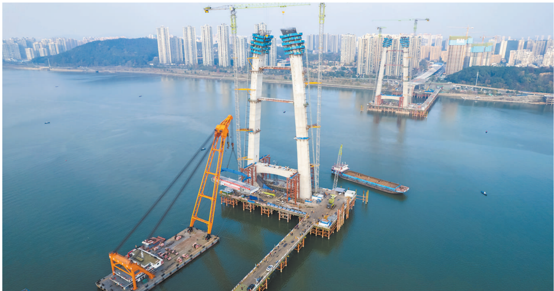
12月12日，由中交一公局承建的长沙兴联路大通道项目双塔斜拉桥首段主梁顺利架设完成。图为当日拍摄的双塔斜拉桥首段主梁架设施工现场（无人机照片）。新华社记者 陈思汗摄
