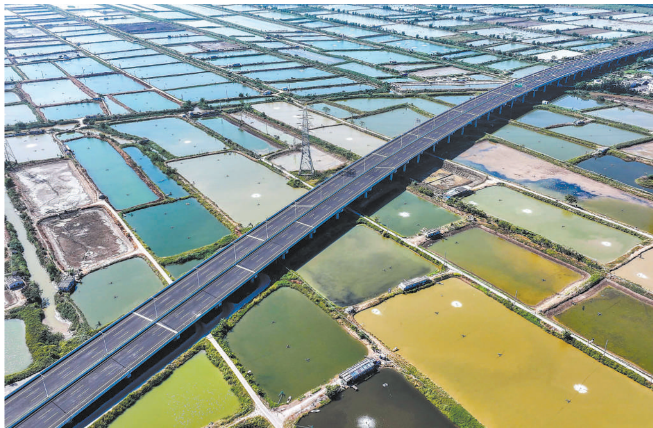
由中铁十一局承建的珠海鹤洲至高栏港高速公路二期工程于12月9日零时通车运营。全长34.5公里的鹤洲高速东连珠海澳大桥西延线，西接黄茅海跨海通道，共同组成粤港澳大湾区基础设施“硬联通”交通主干线之一。图为鹤洲高速南水互通引桥跨越一片水产养殖区（12月8日摄，无人机照片）。新华社记者 刘大伟摄
