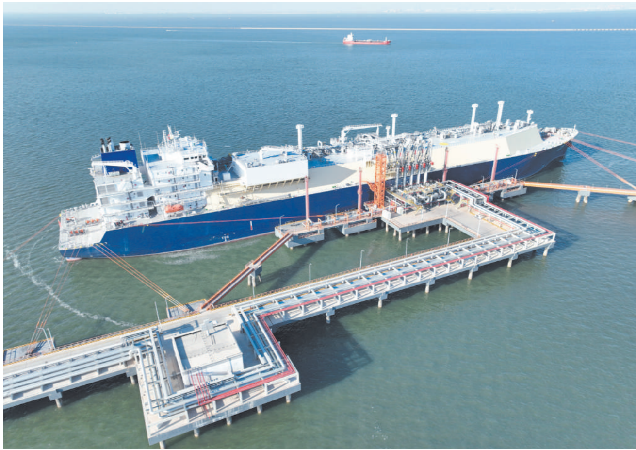
今年冬季供气工作开展以来,中国石化天津LNG(液化天然气)接收站已累计接卸船舶7艘,气化外输天然气超4亿立方米,发挥冬季调峰供气职能,为华北地区经济社会发展和民生需求提供有力保障。图为12月1日,“少林”号LNG运输船靠泊在中国石化天津LNG接收站2号泊位(无人机照片)。
