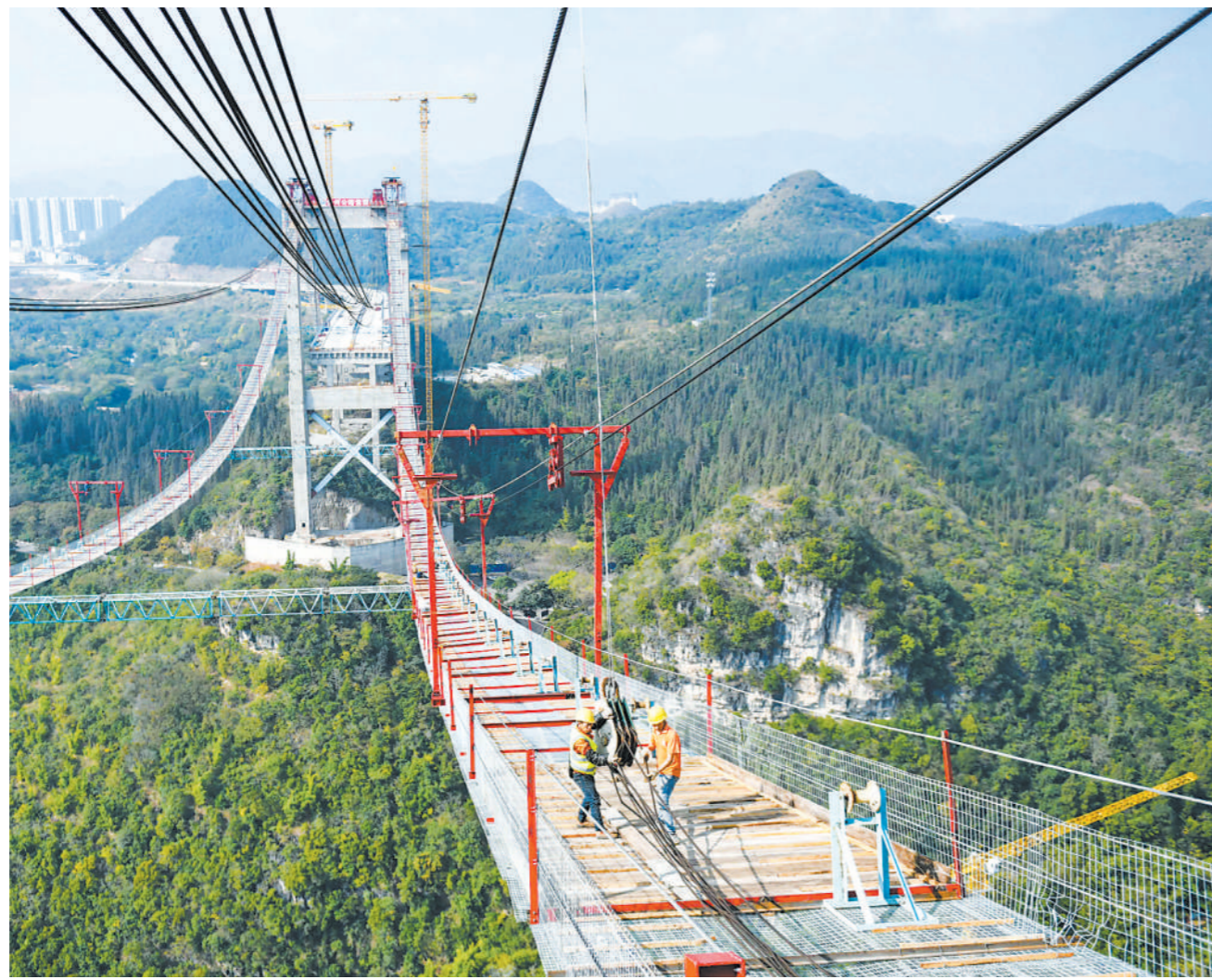
11月25日,贵州省黔东南苗族侗族自治州兴义市金州大桥首根主缆索股顺利牵引,标志着大桥正式进入主缆架设阶段。金州大桥是贵州省跨径最大的市政悬索桥,是连接兴义市和义龙新区的重要城市通道。图为当日工人在兴义市金州大桥建设工地施工。 新华社发
