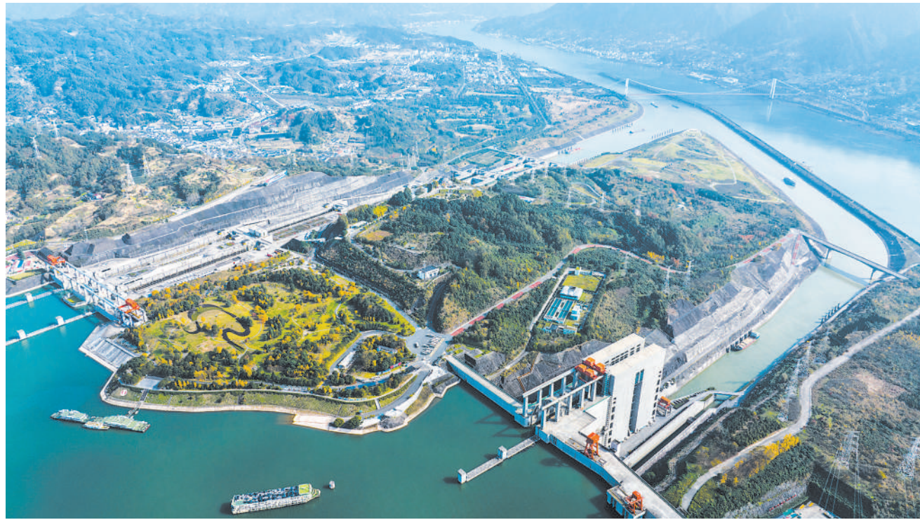
11月24日,在湖北省宜昌市,船舶有序通过三峡船闸和升船机(无人机照片)。截至23日18时,三峡枢纽航运通过量达1.6亿吨,已突破历年最高水平。 新华社发
