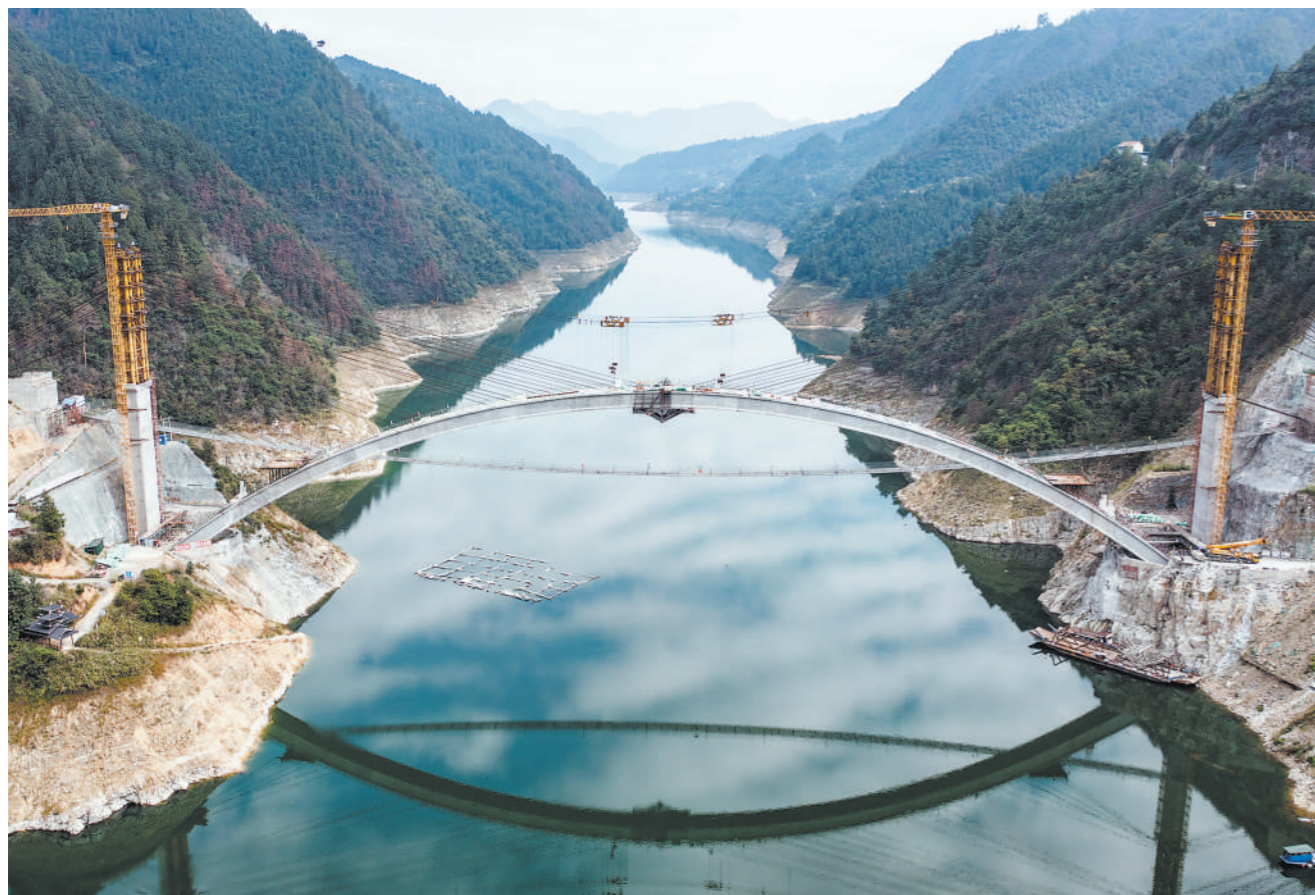
10月23日,位于贵州省黔东南苗族侗族自治州剑河县境内的锦绣大桥主拱顺利合龙(无人机照片)。
