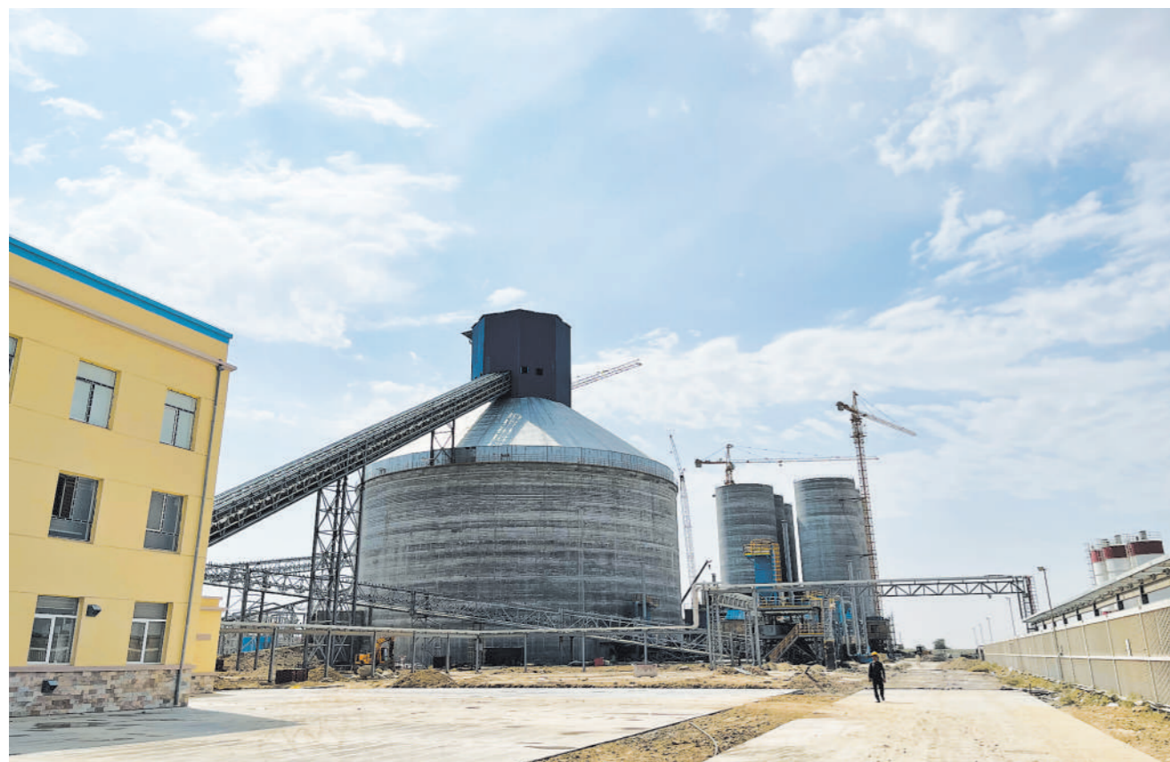
9月26日，乌兹别克斯坦撒马尔罕日产7500吨熟料水泥生产线项目举行点火仪式。该项目由中国能建投资，是中亚地区单体规模最大的单条熟料水泥生产线。图为在乌兹别克斯坦撒马尔罕拍摄的水泥生产线项目熟料库。
