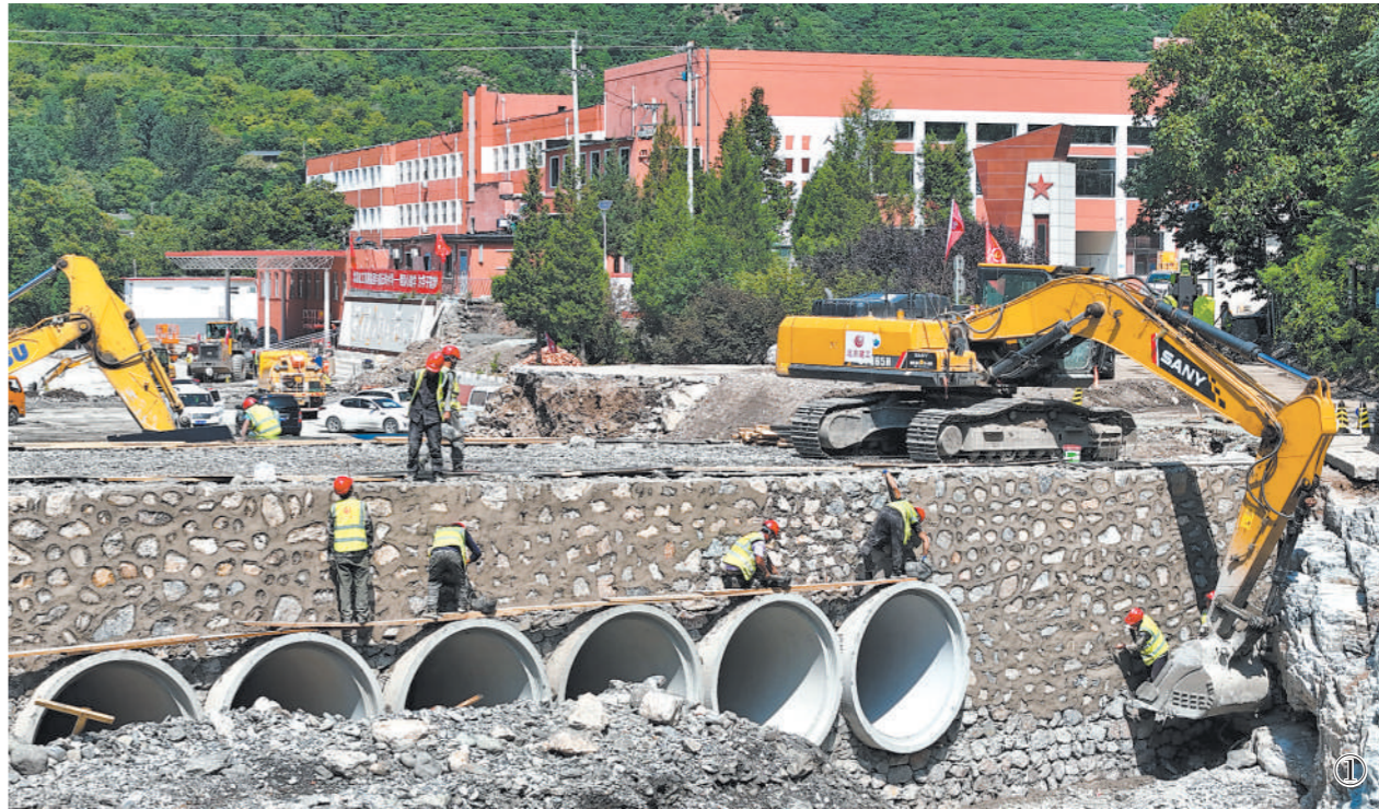
图①:8月23日,在北京市房山区霞云岭中心小学,施工人员在抢建被洪水冲毁的学校与外界通行的新桥梁。受特大暴雨灾害影响,霞云岭中心小学部分校舍受损,操场局部坍塌,学校门前道路和桥梁被洪水冲毁。连日来,抢险施工队伍在霞云岭中心小学进行灾后恢复重建工作,全力保障学生开学。新华社记者 鞠焕宗摄
