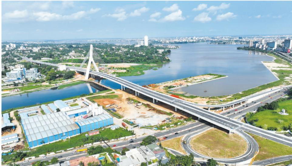
由中国路桥工程有限责任公司承建的科特迪瓦经济首都阿比让科迪迪斜拉桥项目12日竣工通车。科迪迪桥项目主线总长约1.63公里，其中主桥为钢梁单塔斜拉形式，全长630米、主跨长200米、主塔高108.6米。
